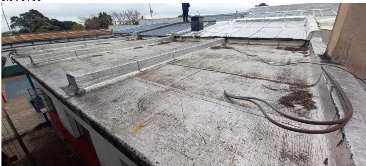
Cubierta comedor a reimpermeabilizar
