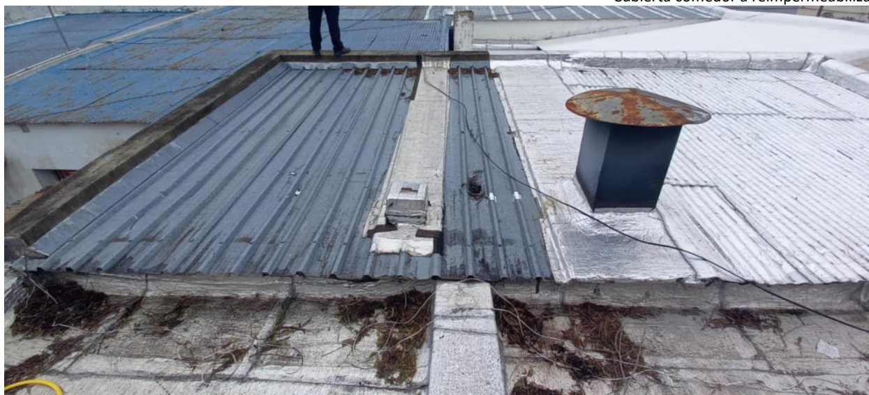
Cubierta de chapas de cocina a sustituir
