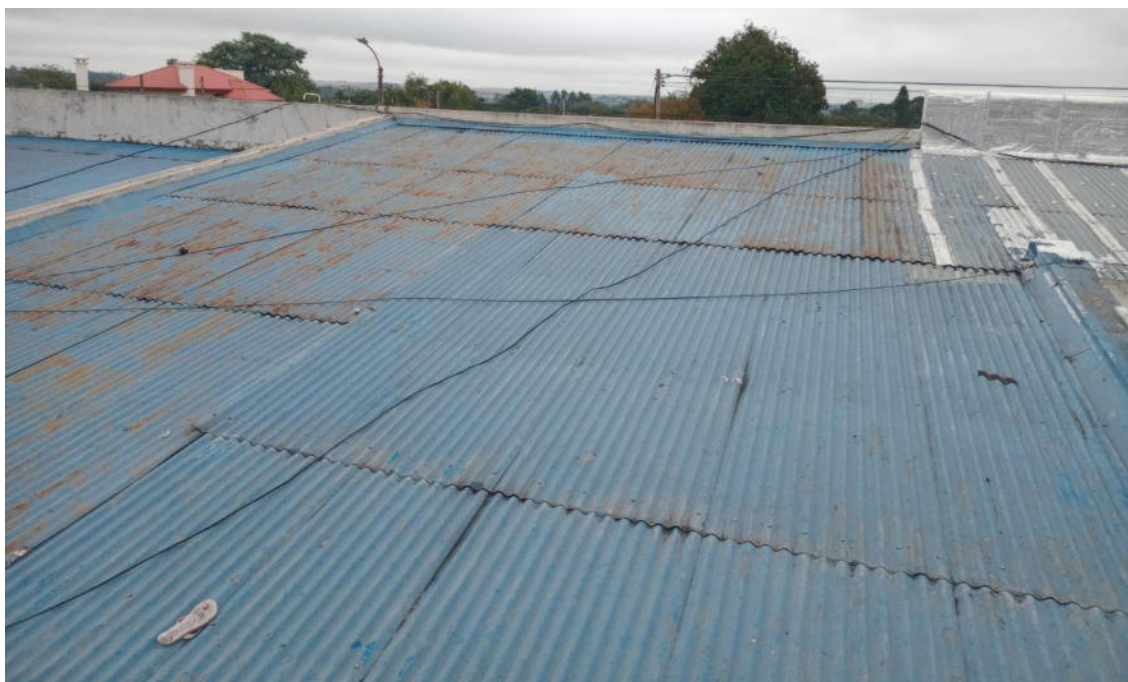
Cubierta de chapas a reparar
